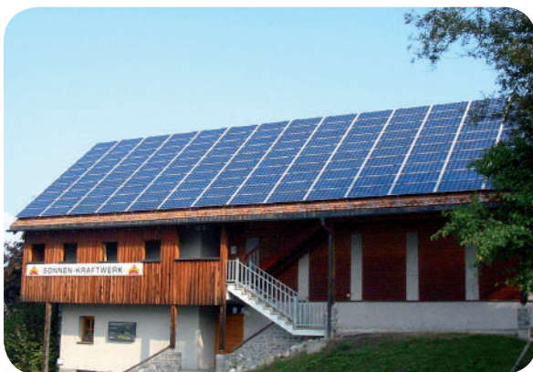
Installation collective de panneaux solaires photovoltaïques dans le Vorarlberg (Autriche).
