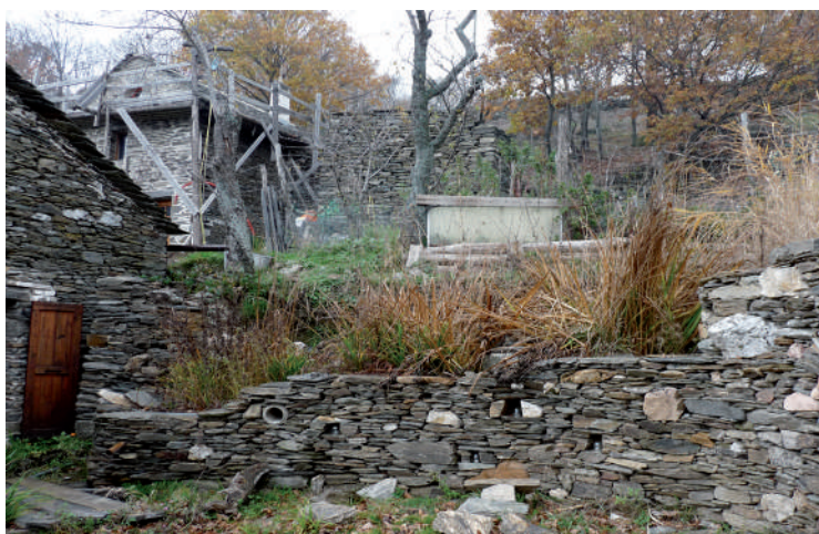
Assainissement par filtres plantés, écogite de Vieljeuves (48)
