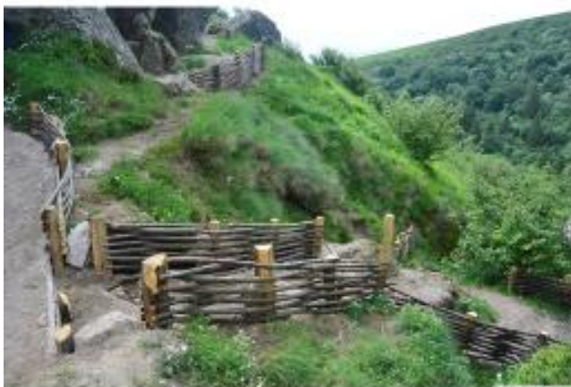
Réalisation d'embranchements (dont caissonnage) et tressages en perches de châtaigner - Equipes Parc
