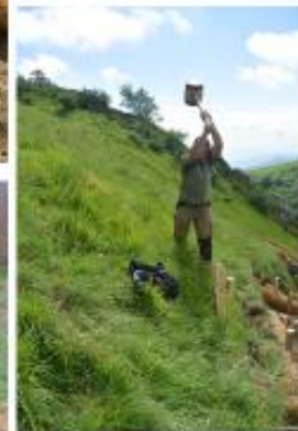
Mise en place des boudins en fibre de coco pour tenir les talus (équipe Parc, aide ponctuelle Lycée Agricole -chantier école)
