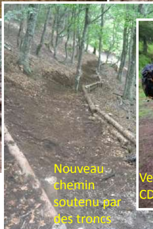
Réalisation du gabion
