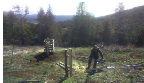
Installation d'un portillon Puy de Combegrasse © SMPNRVA
