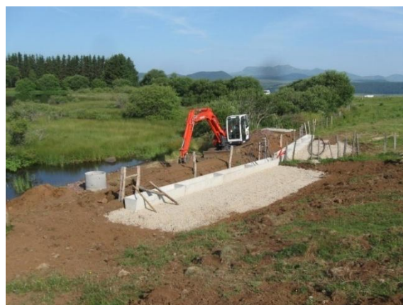
Chantier d'aménagement des abreuvoirs en retrait des berges du lac (© SMPNRVA)
