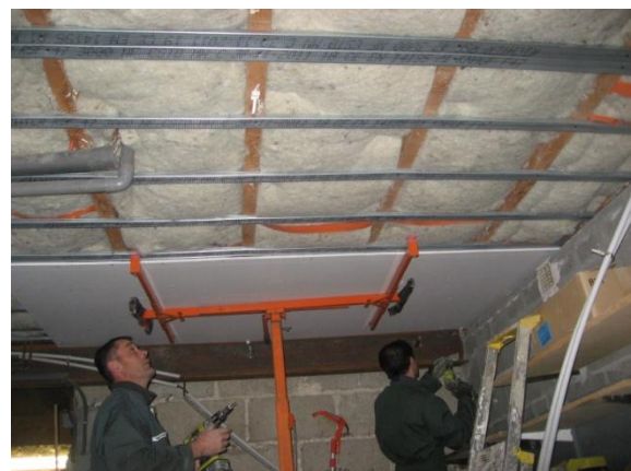
Travaux d'isolation en laine Rava réalisés en interne (© SMPNRVA)
