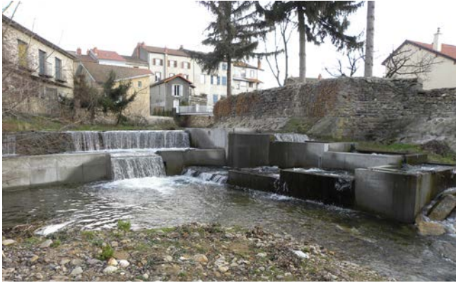
Travaux de restauration sur l'Allagnonnette (passe à poissons) à Massiac. © SMPNRVA, C. Birard, 2013.
