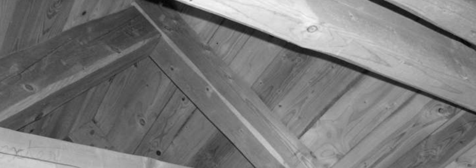
Détail de charpente © SMPNRVA
