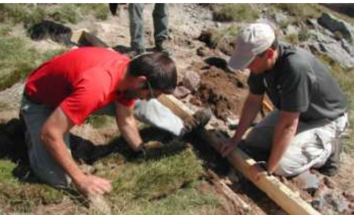
Travaux réalisés par les gardes nature du SMPNRVA © SMPNRVA (Thierry Leroy)
