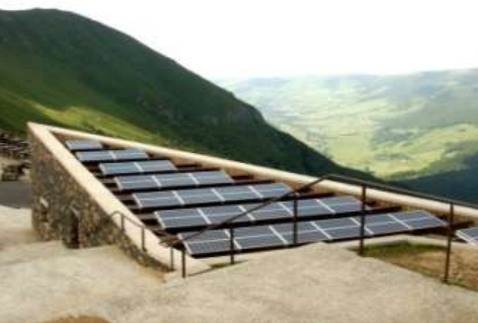
Maison du site du Puy Mary – Massif du Cantal © SMPNRVA
