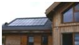
Photovoltaïque sur toiture de maison © C. Camus
