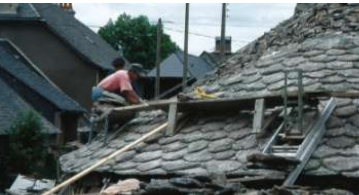
Rénovation d'une toiture en lauzes © SMPNRVA
