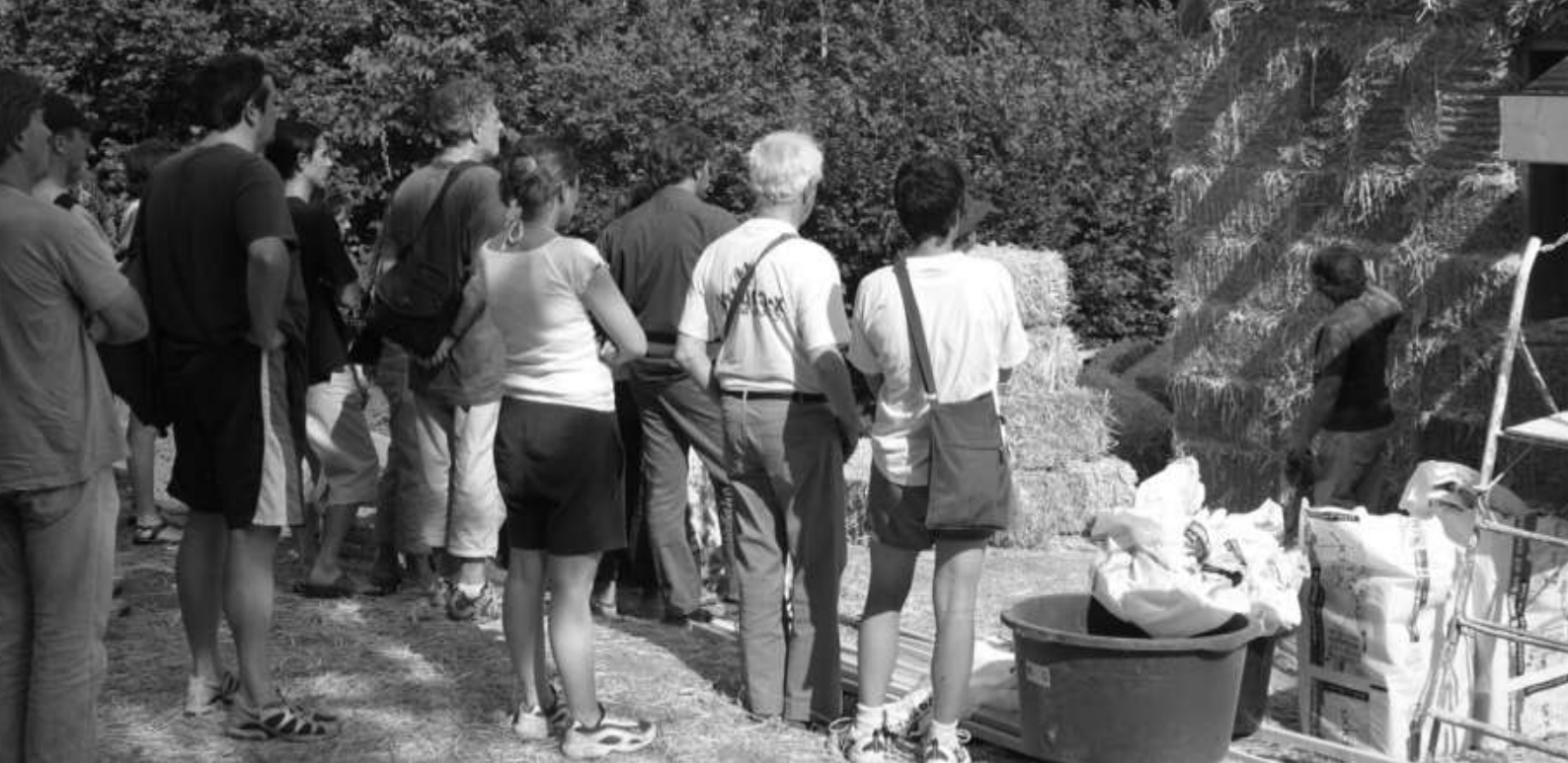
Chantier de construction paille à Manson © SMPNRVA
