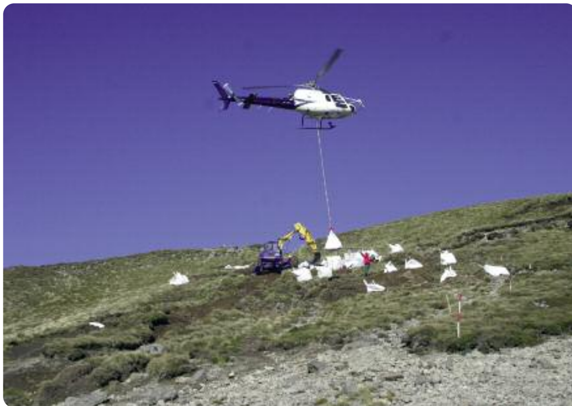
Transport des matériaux de comblement par hélicoptère
