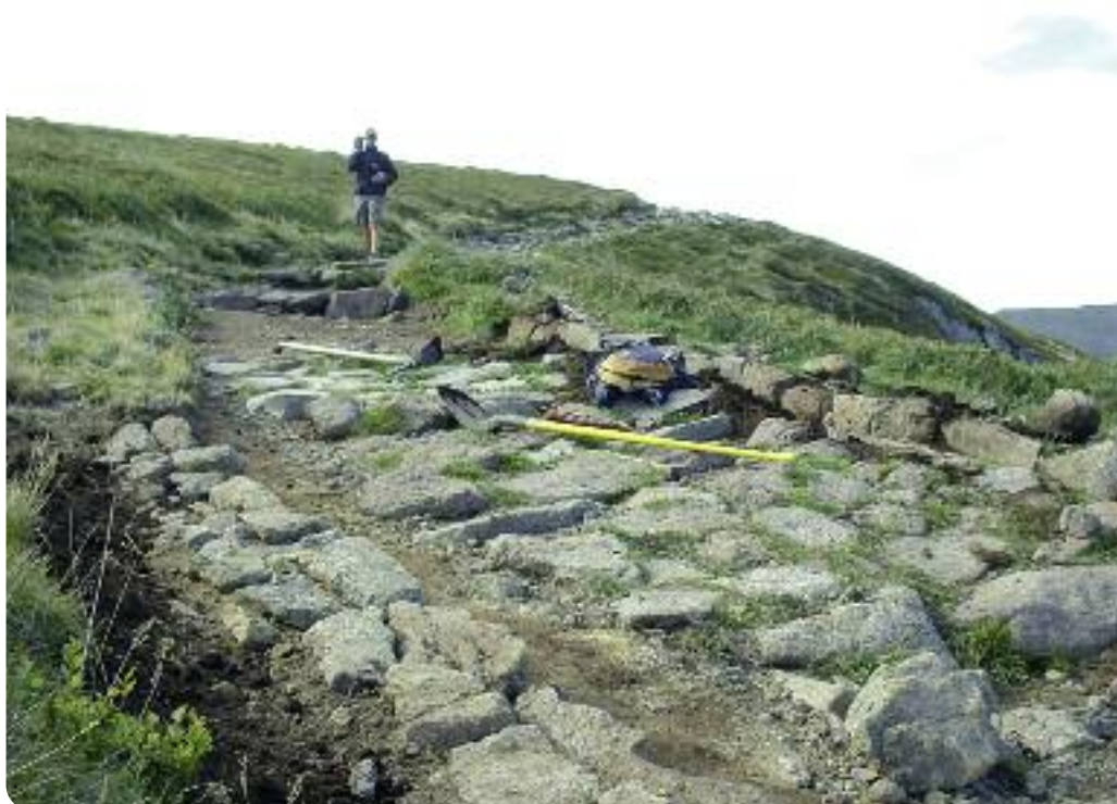
Travaux de restauration
