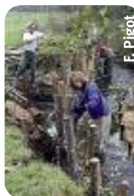
Travaux de restauration du ruisseau de Randanne
