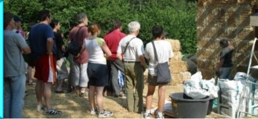
Chantier de construction paille à Manson © SMPNRVA
