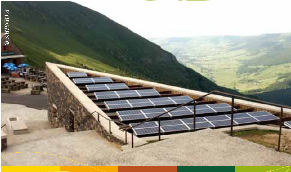
L'équipement photovoltaïque de la maison de site du Puy Mary au Pas de Peyrol
