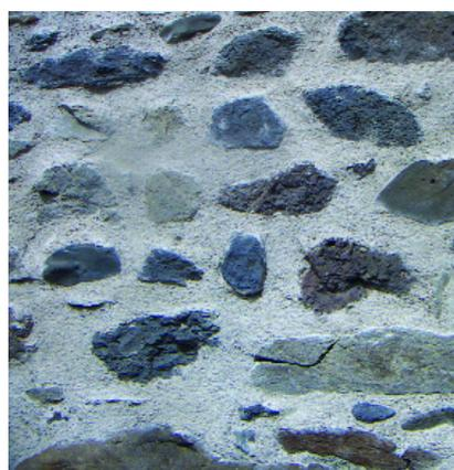
*Jointoyées à la chaux naturelle additionnée de sables et pigments locaux, les pierres restent parfois apparentes.*
